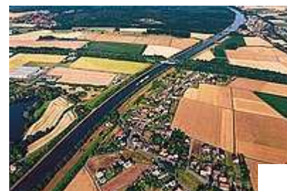
Nördlich der B 482 soll der neue Containerumschlagplatz (Regioport) entstehen. | Foto: Edwin Dodd
